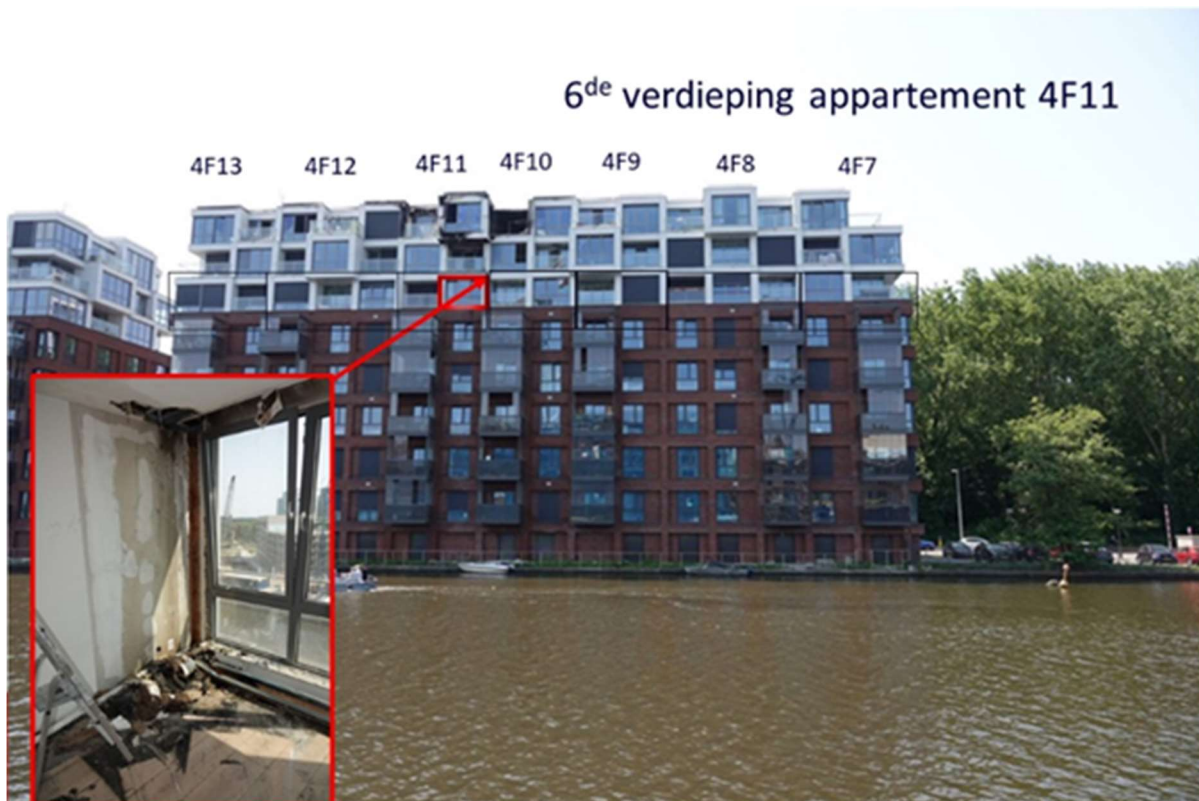
Afbeelding 3.2 De schade op de zesde verdieping
