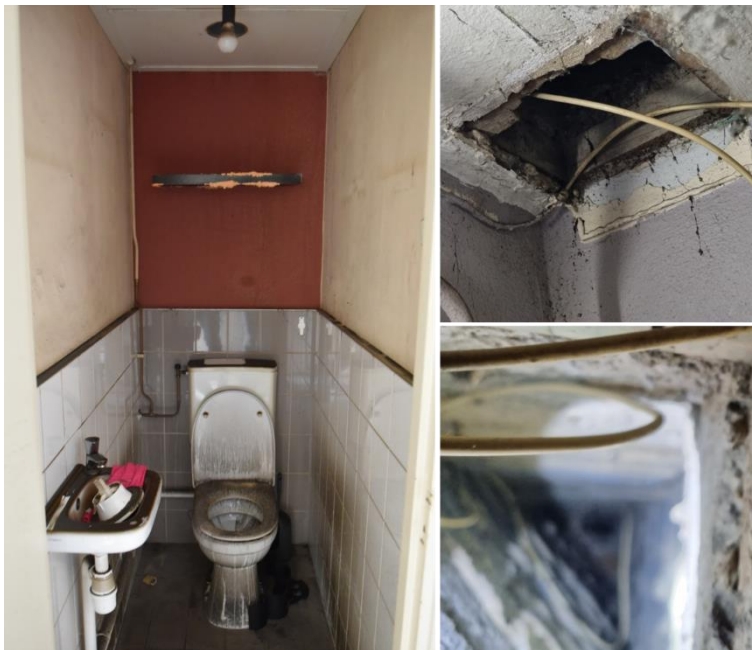
Figuur 87 Traject rookverspreiding naar toiletruimte
