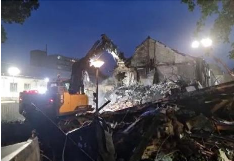
Figuur 26 Sloop van woning nr. 42 t/m 48
