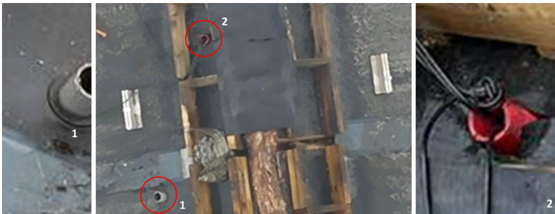
Figuur 113 Doorvoeringen in de dakconstructie
