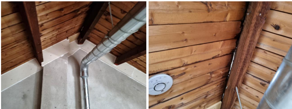
Figuur 15 Nok gezien vanaf de binnenzijde van de zolder van woning nr. 38
