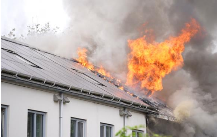
Figuur 35 12:10, Uitslaande brand zolderraam woning nr. 44 Bron: Heitink/Gelrenieuws.nl
