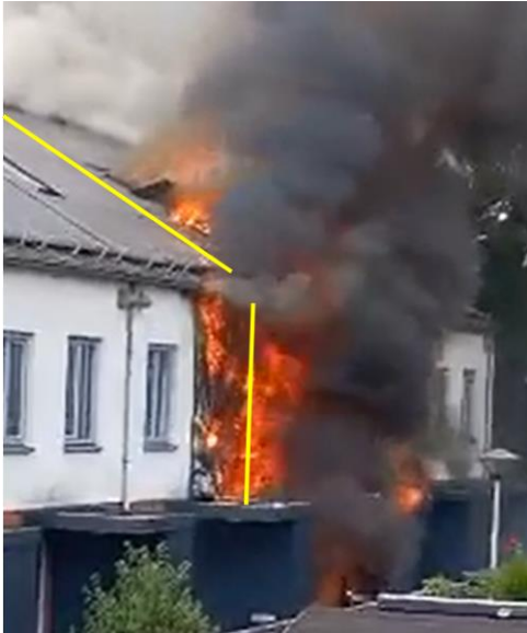
Figuur 5 Beeld van de snelle branduitbreiding naar de gevel van de aangrenzende woning. Bron: Omwonende
