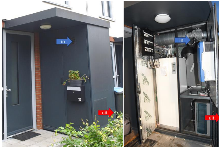
Figuur 119 Energiemodule aan de voorzijde van de woning
