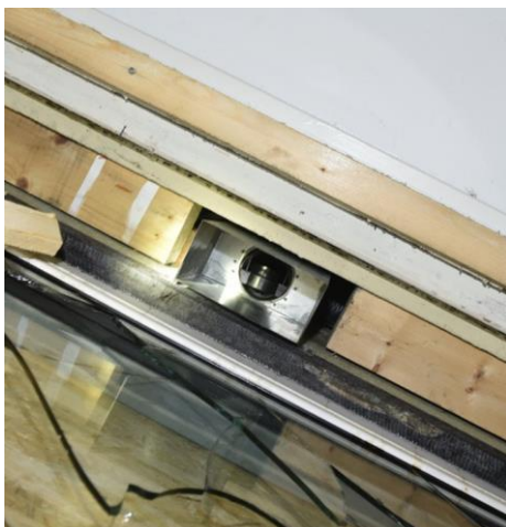
Figuur 77 Open ruimte langs ventilatiekanaal
