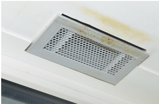
Figuur 74 Ventilatierooster in omtimmering van het raamkozijn
