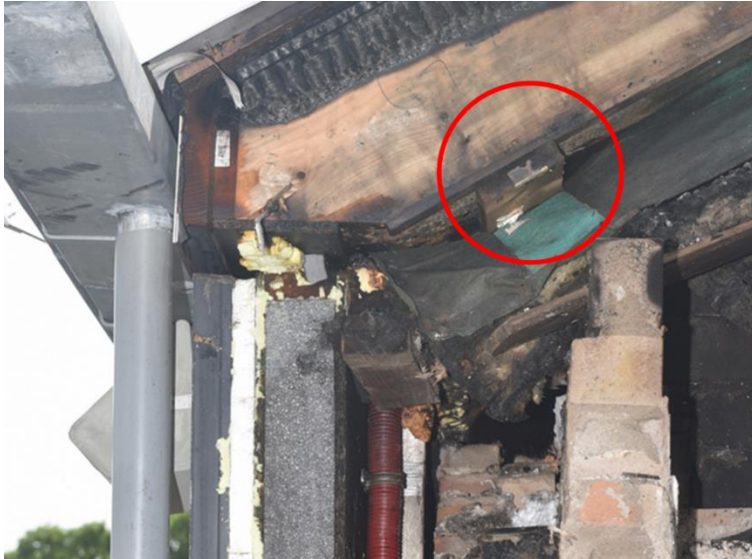
Figuur 88 Balk loopt door over de woningscheidende wand heen
