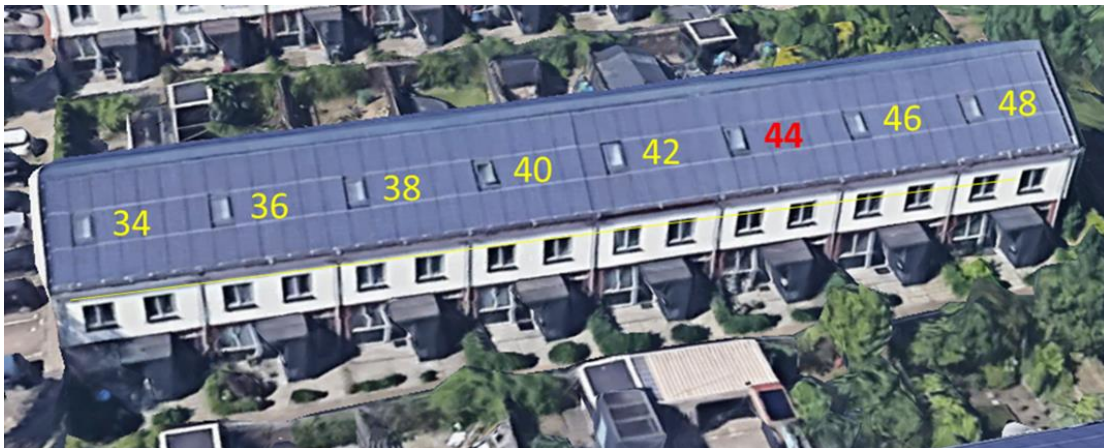
Figuur 7 Weergave van de woningen na de verbouwing. Bron: Google
