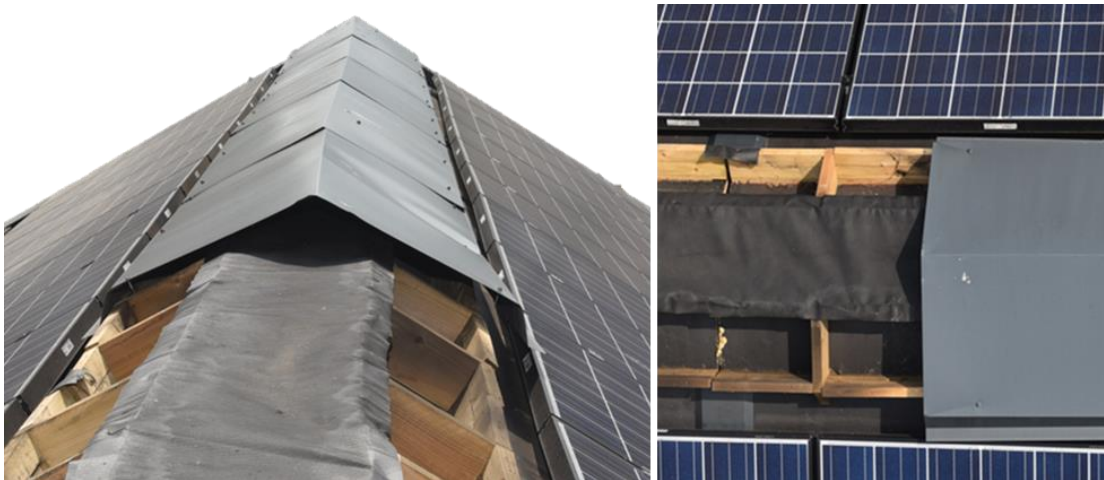
Figuur 109 Nokconstructie
