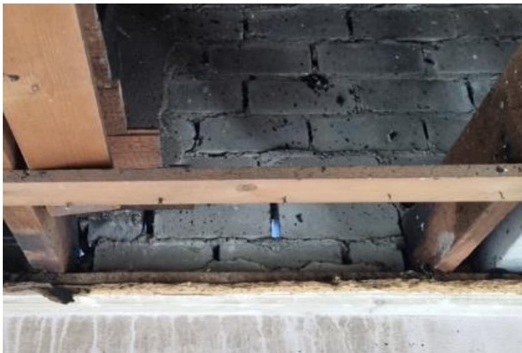
Figuur 97 Openingen ter plaatse van de stootvoegen in metselwerk in bij de ingemetselde vloerbalken
