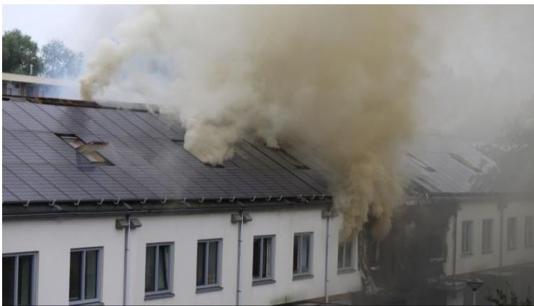
Figuur 44 14:32, Forse rook uit woning nr. 42, rook uit ingeslagen dakraam nr. 40. Bron: Heitink/Gelrenieuws.nl
