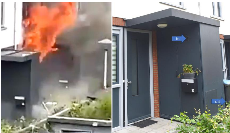
Figuur 60 Beeld uitslaande brand om 11:51 met rook uit energiemodule en foto van energiemodule met in- en uitstroomopening van het ventilatiesysteem. Bron: Omwonende
