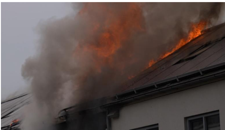
Figuur 69 12:12, Bepaalde branduitbreiding onder de zonnepanelen langs in zijwaartse richting. Bron: Heitinkmedia
