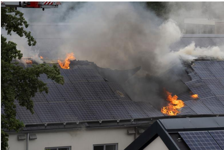
Figuur 42 13:42, Branduitbreiding via de nokconstructie naar woning nr. 46 Bron: Heitink/Gelrenieuws.nl
