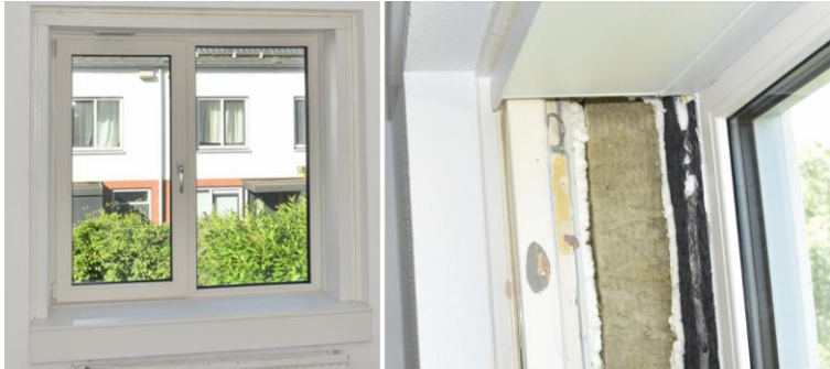
Figuur 98 Raamconstructie met en zonder spouwaftimmering
