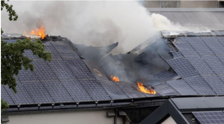
Figuur 70 Branduitbreiding via de nokconstructie naar woning nr. 46 (links) en woning nr. 42 (rechts). Bron: Heitinkmedia/Gelrenieuws.nl
