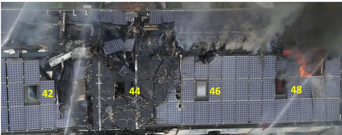
Figuur 71 Branduitbreiding over de nok van woning nr. 46 naar nr. 48
