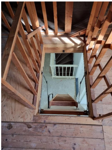
Figuur 117 Geopende vlizotrap naar de zolder
