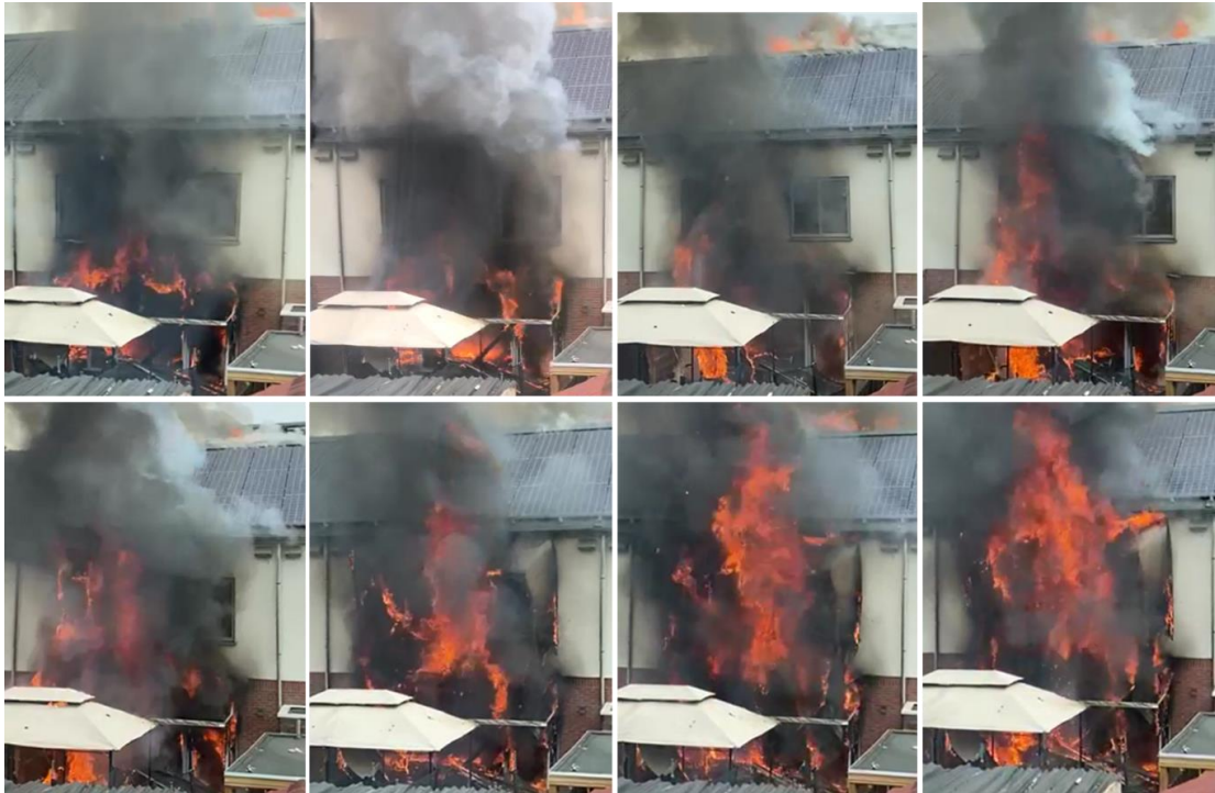
Figuur 64 Branduitbreiding over de achtergevel. Bron: Omwonende
