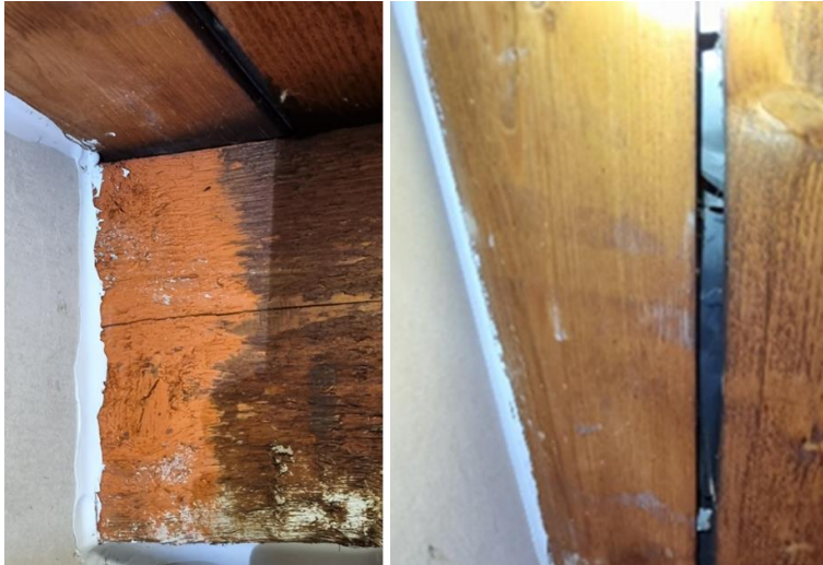
Figuur 112 Ruimte tussen de gording en het dakbeschot en ruimte tussen het hout van het dakbeschot
