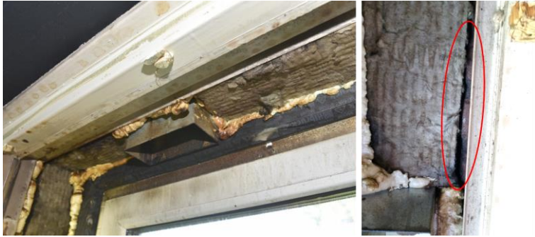
Figuur 75 Spouw die is dichtgezet met steenwol ter plaatse van een raam op de eerste verdieping
