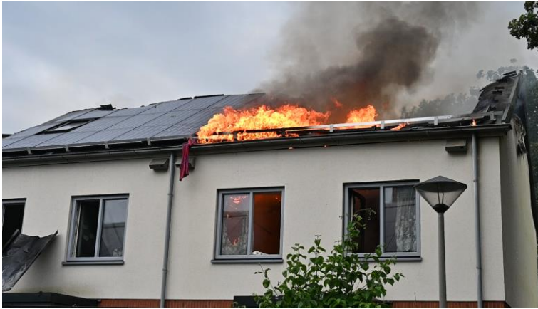
Figuur 52 17:32, vlammen zichtbaar op de 1e verdieping van woning nr. 48. Bron: Heitink/Gelrenieuws.nl
