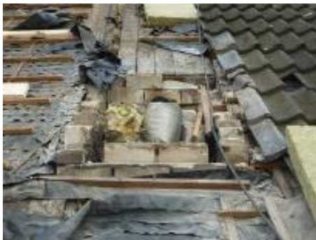
Figuur 105 Verwijderde schoorsteenkanalen ter plaatse van de woningscheidende wand. Bron: Notitie Nieman, 26 januari 2017
