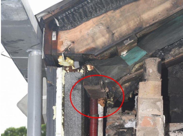
Figuur 82 Verbinding tussen de spouw van de gevel en de spouw van het dak
