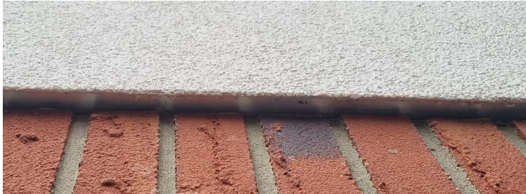
Figuur 92b Profiel van metaal bij overgang steenstrips naar stucwerk
