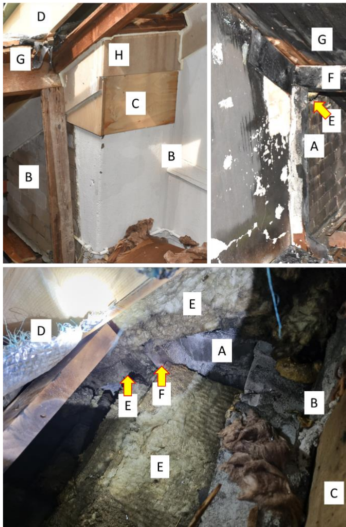
Figuur 106 Scheidingsconstructie ter plaatse van het schoorsteenkanaal bij woning nr. 38
