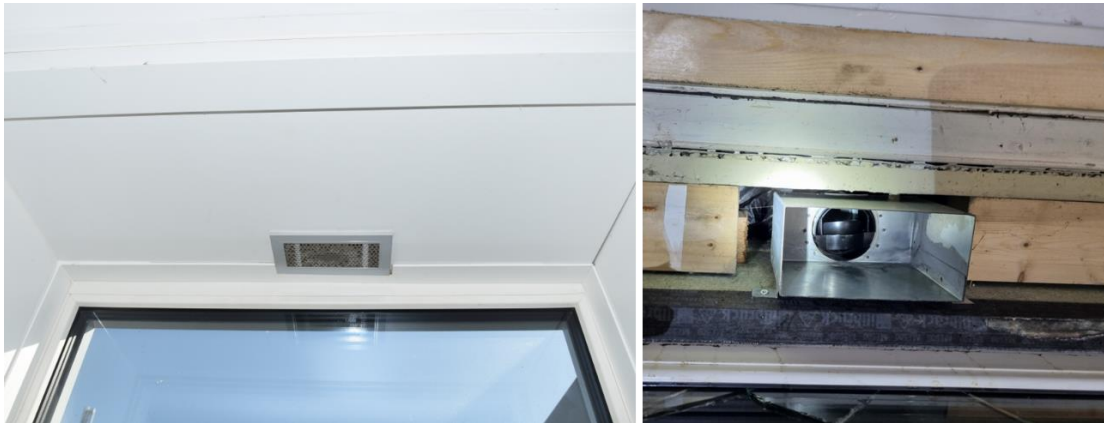
Figuur 99 Ventilatierooster aan de bovenzijde in de aftimmering
