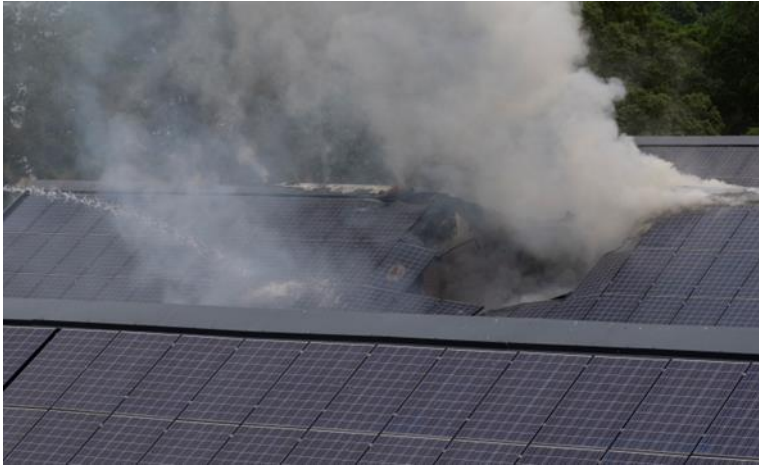
Figuur 41 13:23, achterzijde van de woningen. Bron: Gerard Burgers
