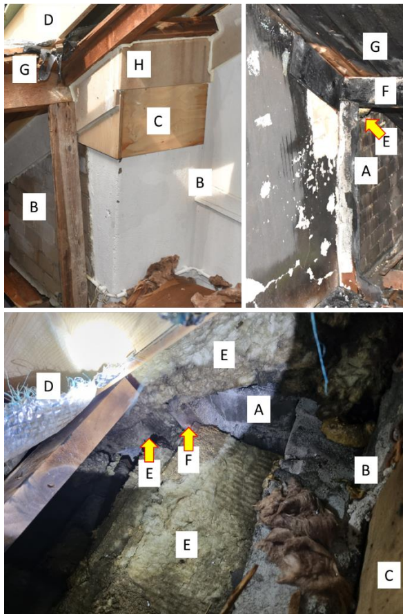
Figuur 84 Scheidingsconstructie ter plaatse van het schoorsteenkanaal bij woning nr. 38
